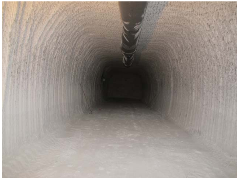
Foto 26: Speicherstrecke 2 nach geschätzten 80 m auf der 800-m-Sohle, NW-Blick (Aufnahmedatum: 02.08.2013)
