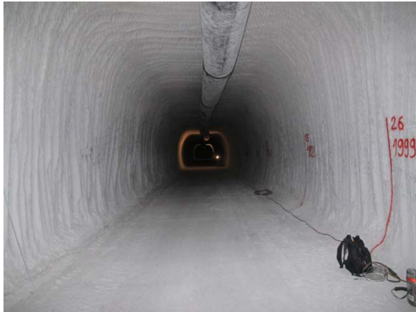
Foto 47: Speicherstrecke 4 nach geschätzten 10 m auf der 800-m-Sohle, NW-Blick (Aufnahmedatum: 29.08.2013)
