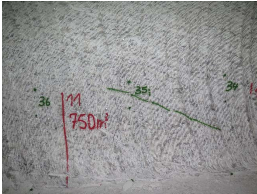
Foto 41: NE-Stoß der Speicherstrecke 3 nach ca. 70 m auf der 800-m-Sohle (Aufnahmedatum: 15.10.2015)
