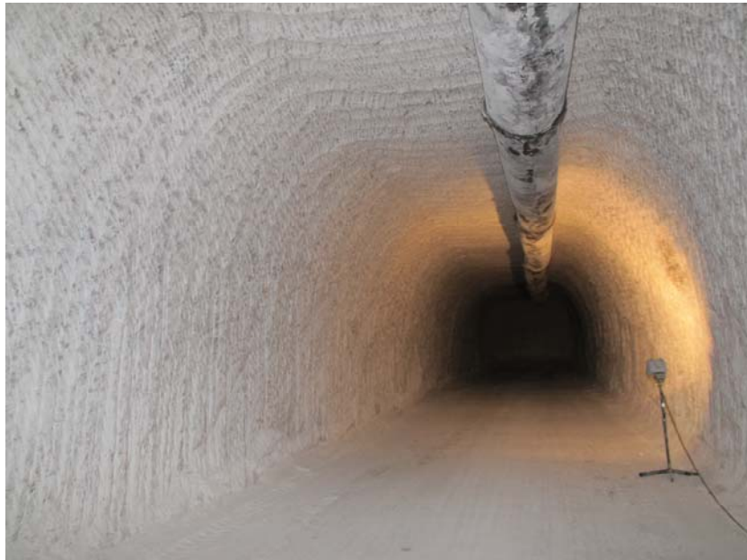
Foto 40: Speicherstrecke 3 nach geschätzten 70 m auf der 800-m-Sohle, NW-Blick (Aufnahmedatum: 30.07.2013)
