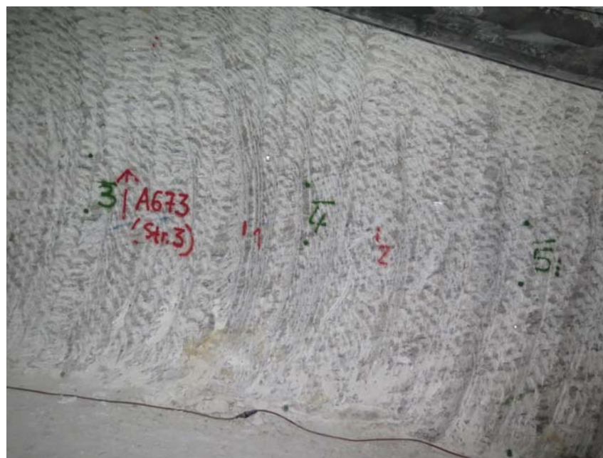
Foto 35: SW-Stoß der Speicherstrecke 3 nach ca. 8 m auf der 800-m-Sohle (Aufnahmedatum: 20.10.2015)
