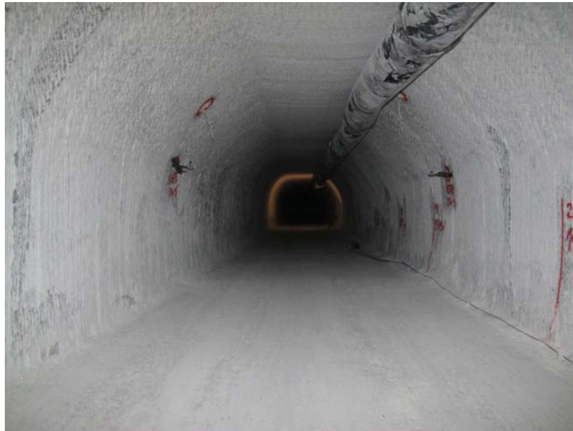
Foto 3: Speicherstrecke 1 bei ca. 12 m auf der 800-m-Sohle, NW-Blick (Aufnahmedatum: 16.08.2013)
