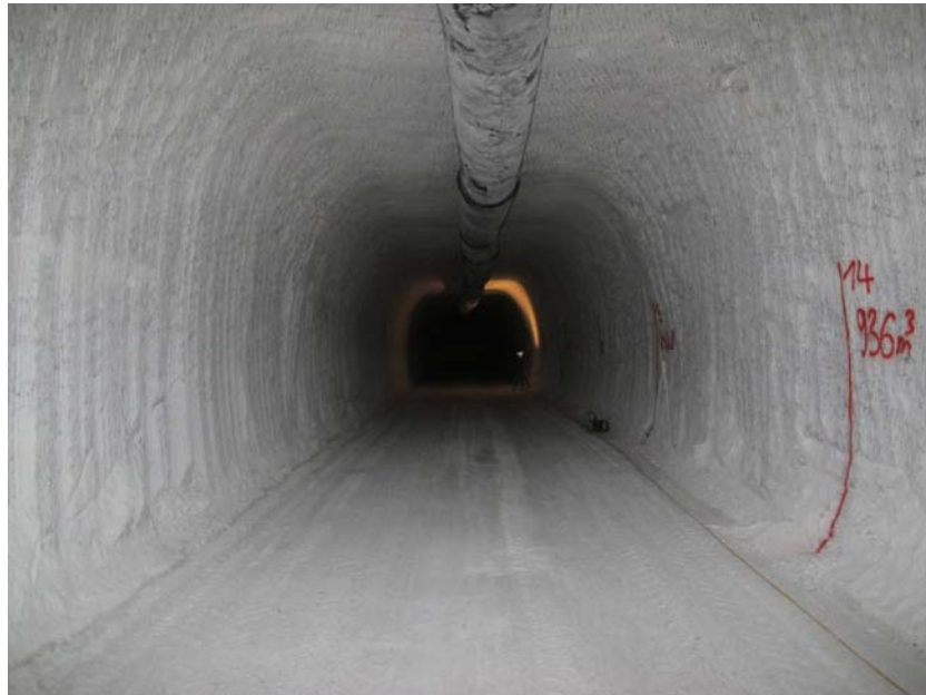
Foto 53: Speicherstrecke 4 (streckenmittig) auf der 800-m-Sohle, NW-Blick (Aufnahmedatum: 29.08.2013)
