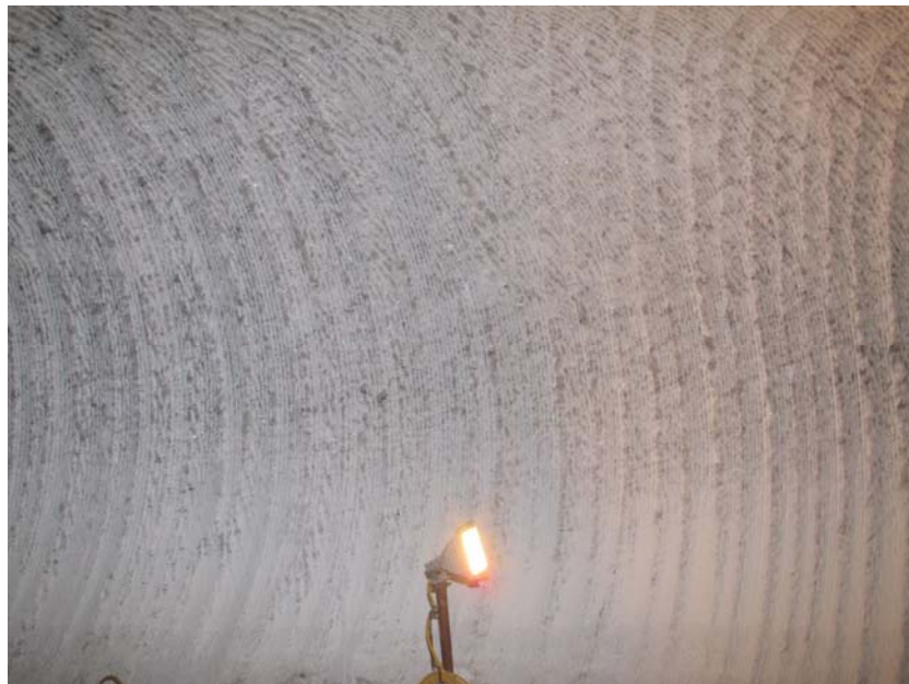
Foto 25: SW-Stoß der Speicherstrecke 2 nach geschätzten 42 m auf der 800-m-Sohle (Aufnahmedatum: 02.08.2013)
