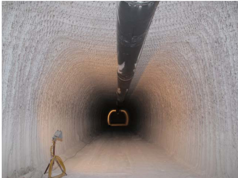
Foto 23: Speicherstrecke 2 nach geschätzten 40 m auf der 800-m-Sohle, NW-Blick (Aufnahmedatum: 02.08.2013)
