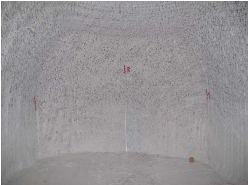
Foto 31: Ortsbrust der Speicherstrecke 2 nach geschätzten 117 m auf der 800-m-Sohle (Aufnahmedatum: 02.08.2013)
