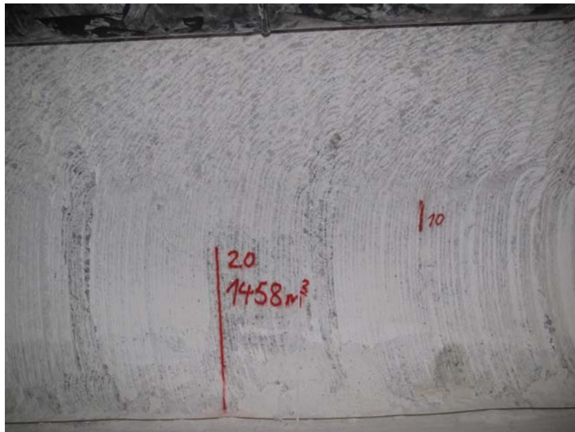
Foto 4: NE-Stoß der Speicherstrecke 1 bei ca. 12 m auf der 800-m-Sohle (Aufnahmedatum: 16.08.2013)
