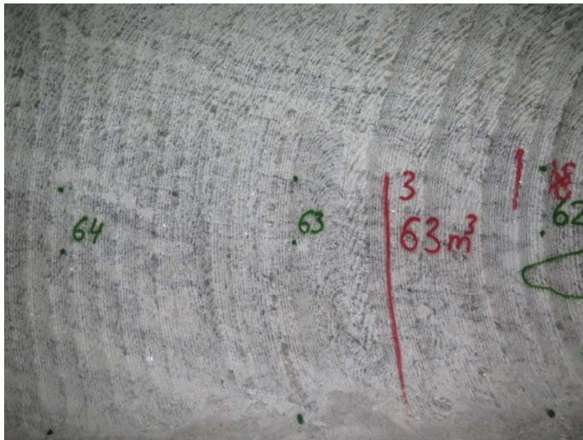
Foto 57: NE-Stoß der Speicherstrecke 4 nach ca. 126 m (NW-Ende) auf der 800-m-Sohle (Aufnahmedatum: 13.10.2015)
