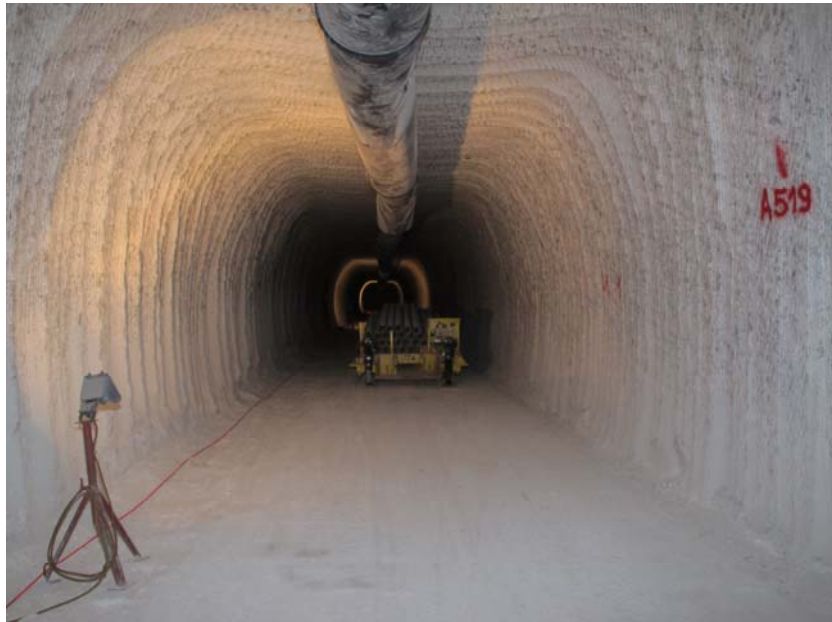
Foto 15: Speicherstrecke 2 auf Höhe der Altbohrung A519 auf der 800-m-Sohle, NW-Blick (Aufnahmedatum: 02.08.2013)
