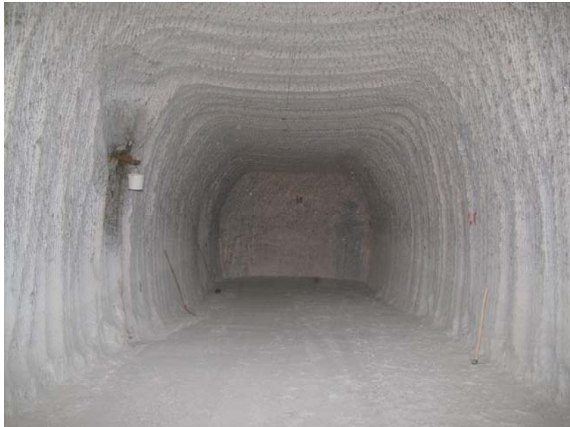
Foto 29: Speicherstrecke 2 nach geschätzten 92 m auf der 800-m-Sohle, NW-Blick (Aufnahmedatum: 02.08.2013)
