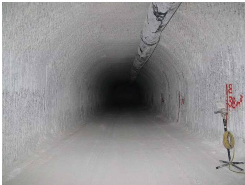
Foto 6 Speicherstrecke 1 bei ca. 65 m auf der 800-m-Sohle, NW-Blick (Aufnahmedatum: 16.08.2013)
