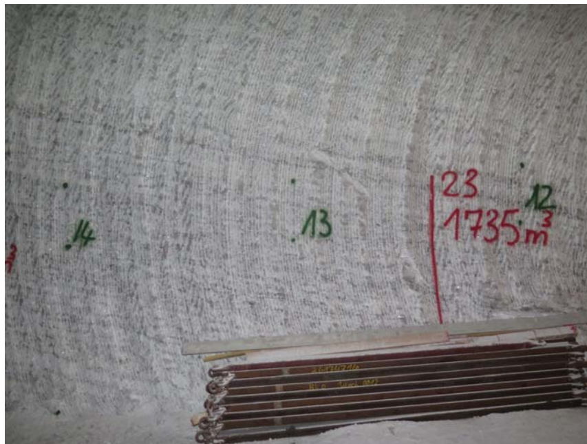
Foto 50: NE-Stoß der Speicherstrecke 4 nach geschätzten 25 m auf der 800-m-Sohle - Übersicht (Aufnahmedatum: 07.10.2015)
