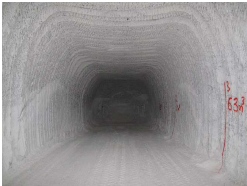
Foto 56: Speicherstrecke 4 (NW-Blick) auf der 800-m-Sohle (Aufnahmedatum: 29.08.2013)
