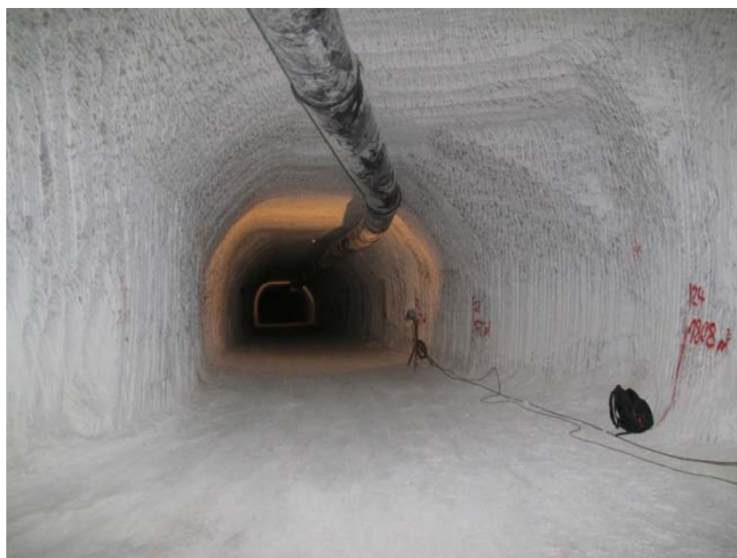
Foto 2: Speicherstrecke 1 auf der 800-m-Sohle, NW-Blick (Aufnahmedatum: 16.08.2013)
