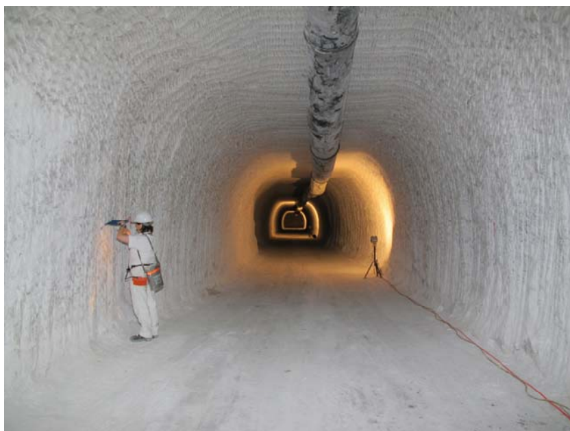
Foto 33: Speicherstrecke 3 nach geschätzten 4 m auf der 800-m-Sohle, NW-Blick (Aufnahmedatum: 30.07.2013)
