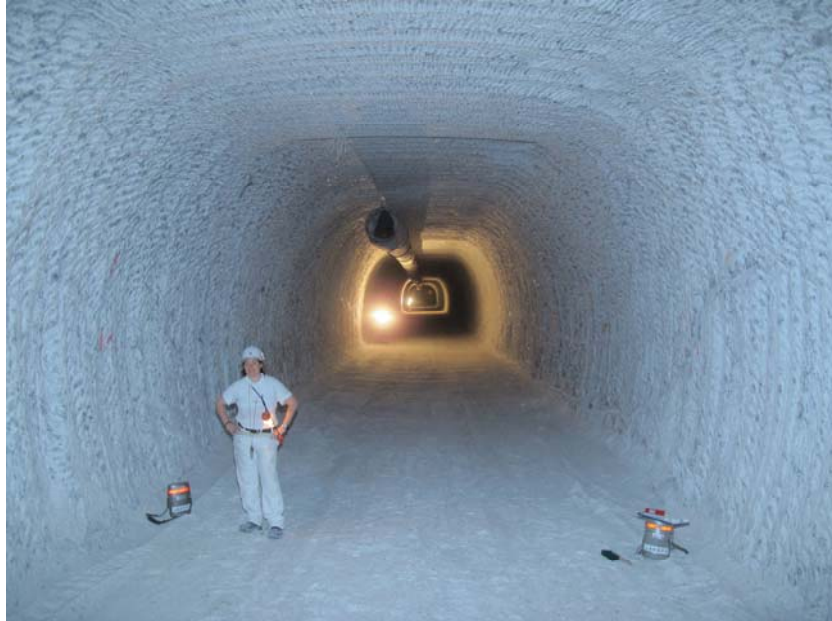
Foto 44: Speicherstrecke 3 auf der 800-m-Sohle, SE-Blick (Aufnahmedatum: 30.07.2013)
