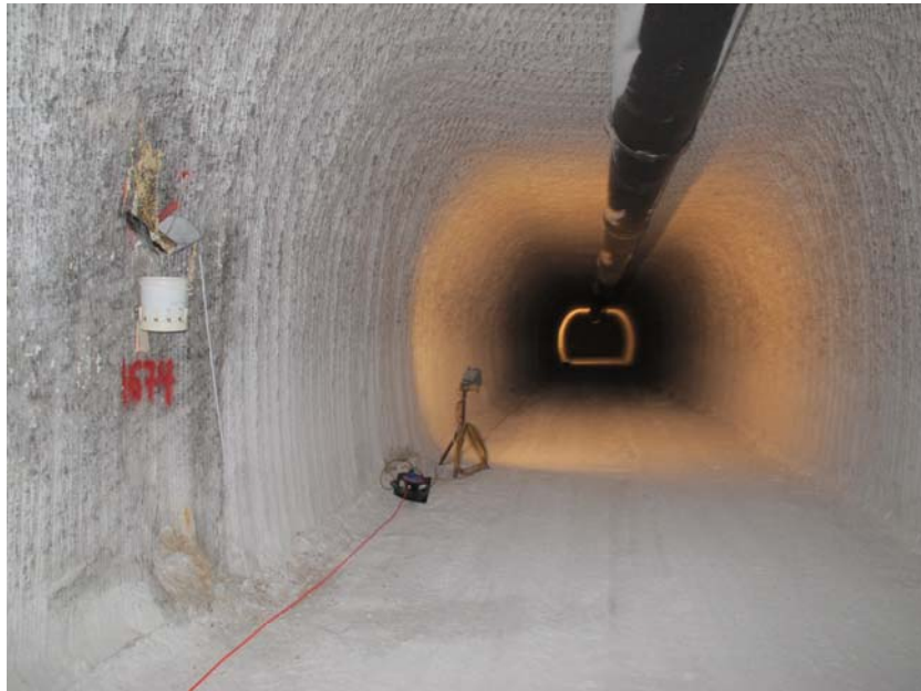
Foto 19: Speicherstrecke 2 auf Höhe der Kataster-Lokalität L800014 (Altbohrung A674), NW-Blick (Aufnahmedatum: 02.08.2013)
