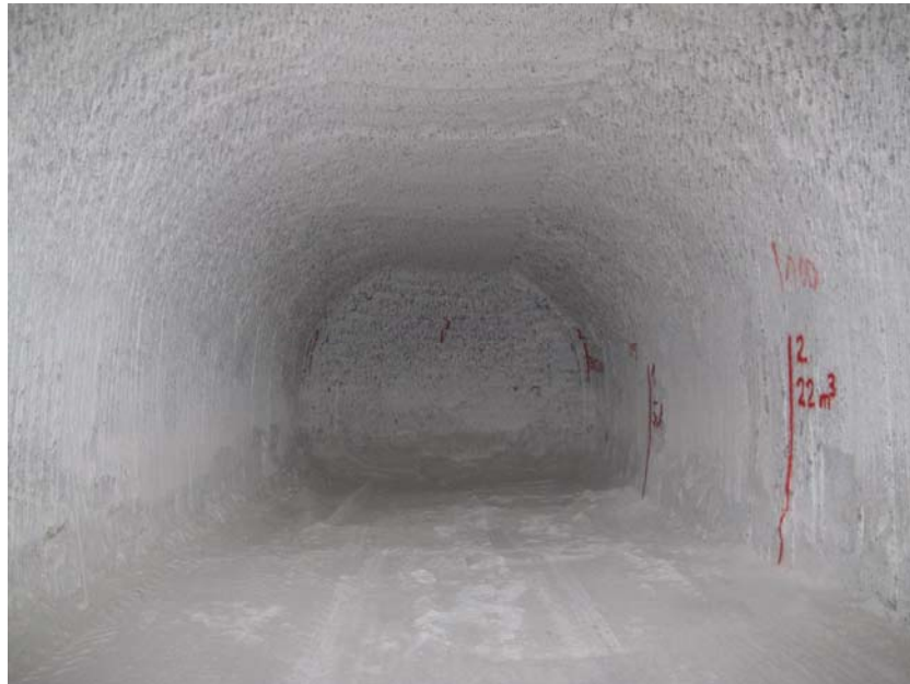
Foto 9: Speicherstrecke 1 bei ca. 100 m auf der 800-m-Sohle, NW-Blick (Aufnahmedatum: 16.08.2013)
