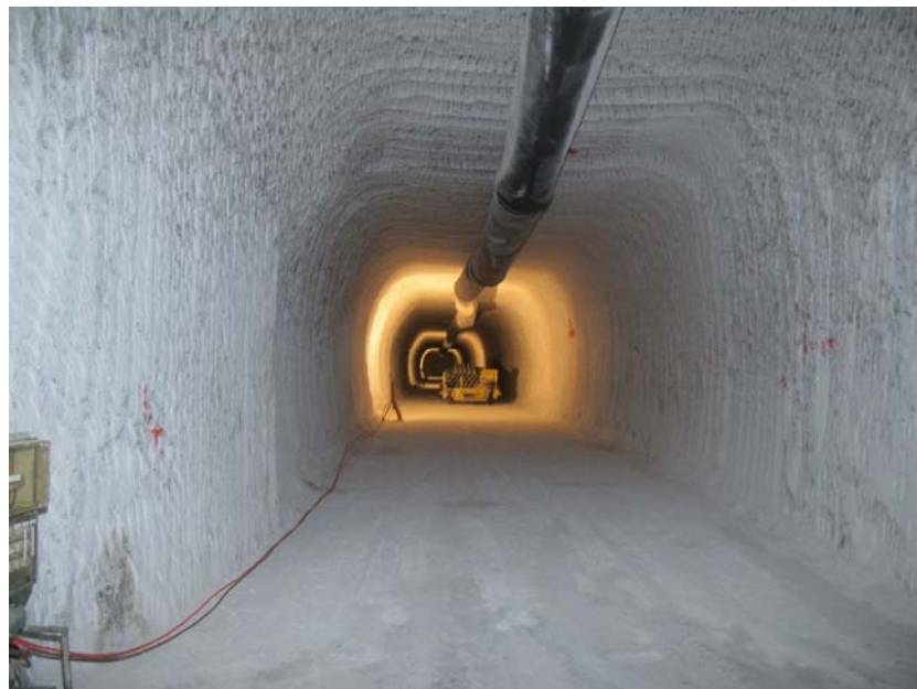
Foto 14: Speicherstrecke 2 auf der 800-m-Sohle, NW-Blick (Aufnahmedatum: 02.08.2013)
